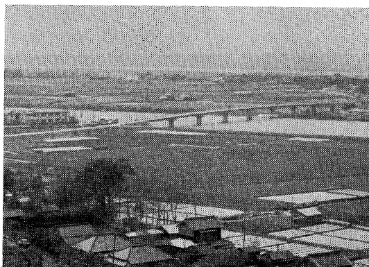
潮来大橋全景
