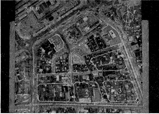
写真一3 大阪駅前市街地整備区域 (鎖線内は計画区域、数字は街区番号)
