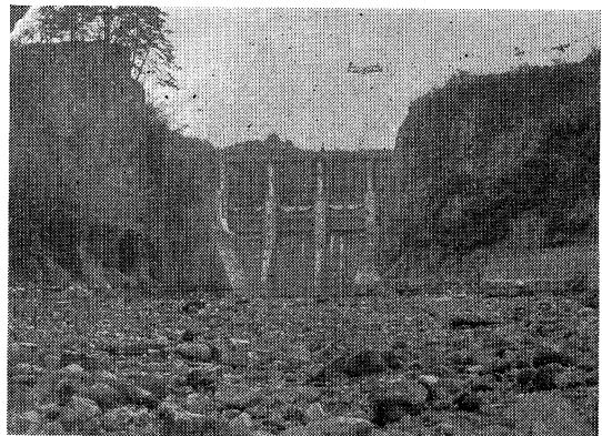
蘭原第 2 発電所
