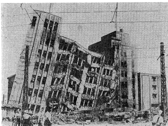
写真-2 同上的大和ビルの柱の破壊状況
