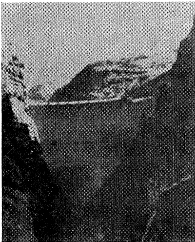
事故発生後のダムを下流より望む
