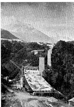
1964年に開催される冬期オリンピックの街インスブルグ市の近くで、オリンピックまでの完成を目指としたアウトバーン橋 Europabrücke (写真上) の工事がすすめられている。この橋は橋脚の高さがヨーロッパで一番高く、ドイツ側をPC構造(スイス, ベルン市の Losinger 社
