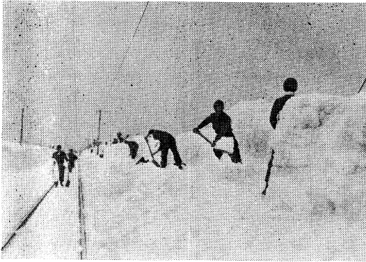
写真-2 鉄橋上における雪捨作業
