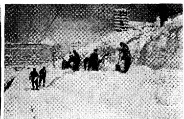
小千谷駅構内段切り作業
