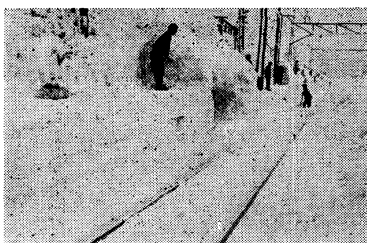
長岡～北長岡間下り本線段切り作業
