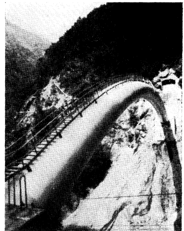
写真-2 楠之木沢水路橋
