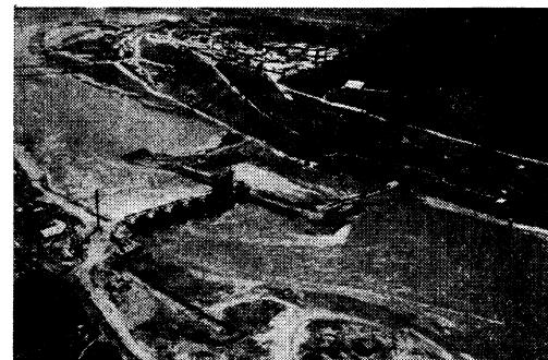
行ないつつ掘削にかかり、ただちに遮水壁ケーソンA型8基、えん堤ピヤー支持のためのB型8基および河川切りかえ後の縦締切ケーソンA型5基、ウェル4基を同時に施工した。ダム標準断面およびケーソン配置は図-2、3のとおりである。
