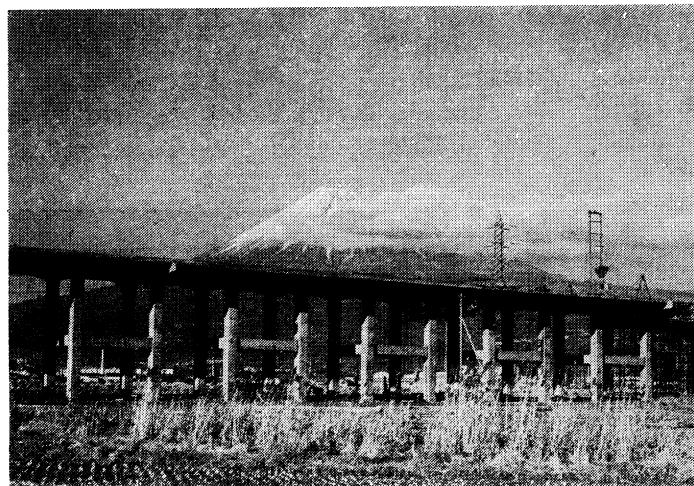
骨ラーメン構造とし、柱を円形断面としたものについて、特に柱と柱の結合部の構造について検討した結果、遠心铸造钢管を使用した新しい仕口形式が採用されたが、試験結果によると、応力の流れが円滑で隅角部における応力集中も少なく、円形柱と箱形ばかりの仕口として、耐力も十分であり、工作も簡単で、好結果を得ることができることが確かめられた。
