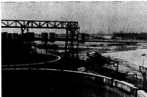
摩耶埠頭第2突堤の鋼板セル岸壁
