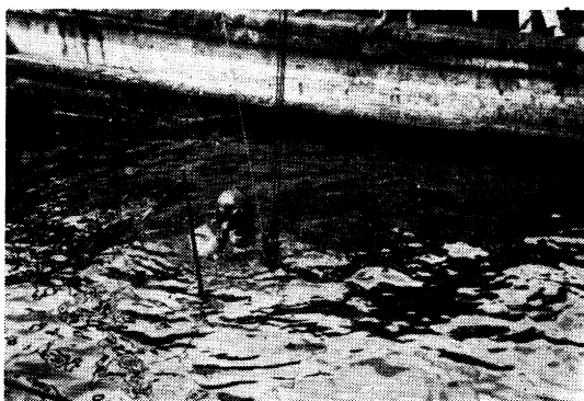
(d) 潜水夫によりバケットを所定の位置へ
