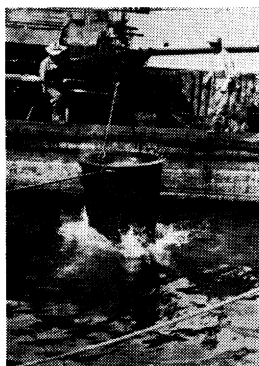
(c) バケットを流し込み位置へ
