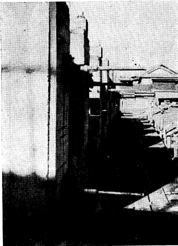
写真-3 型わく支柱およびジャッキ
