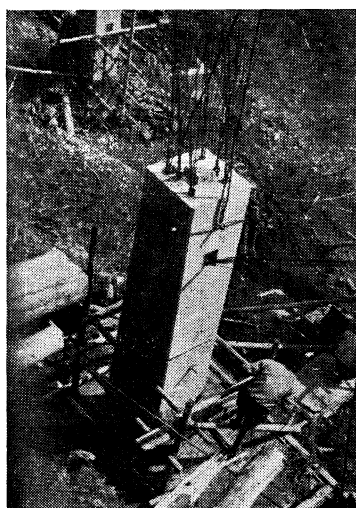
写真-2 脚柱組立状況
