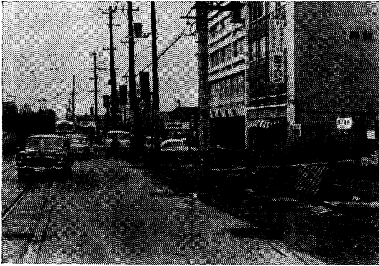
工事の隘路となる占有物件（放 4）
