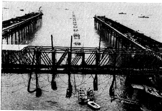
A 管ひき出し状況
