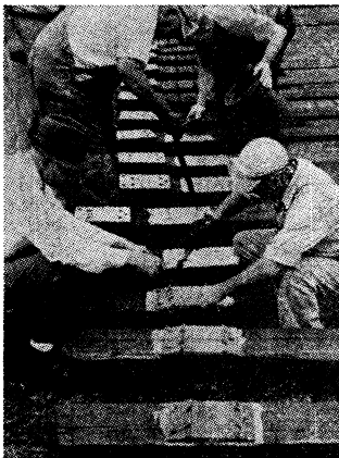
写真-1 タイプレートはエポキシ接着剤の上に置かれたあと、犬くぎ孔にあるくぎで固定される
