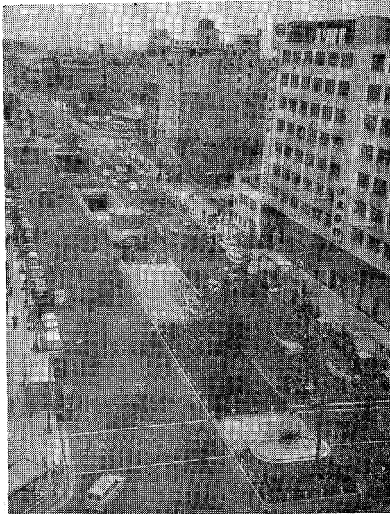
東京都八重洲駐車場
