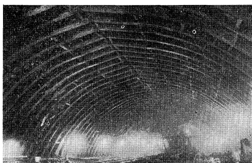
写真-3 上部半断面に使用した H 形鋼
