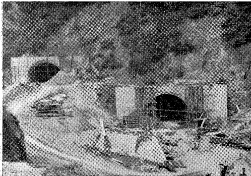
天王山トンネル東坑口設備 (大山工事の高架が遠望できる)
