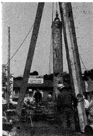
写真-5 鉄筋籠を吊り込む
