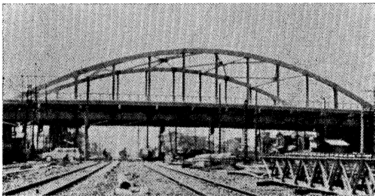
側面から見た蒲田陸橋
