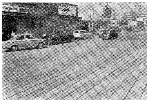
写真-6 エコンドッキの敷設状況
