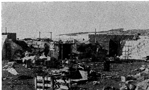
建設進む昭和基地 (34 年 1 月 30 日)
