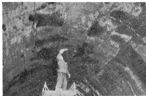
上記は測定中の現場写真
