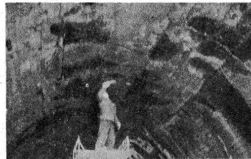
上記は測定中の現場写真
