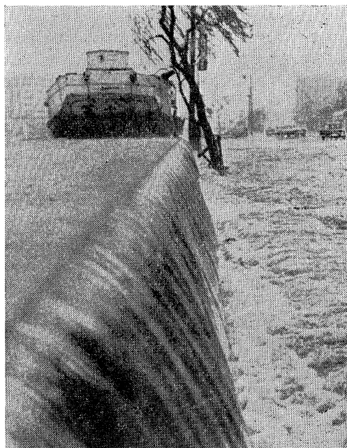
防潮堤を越して流れこむ高潮、瞬間最大風速 50.6 m (大阪府にて)
