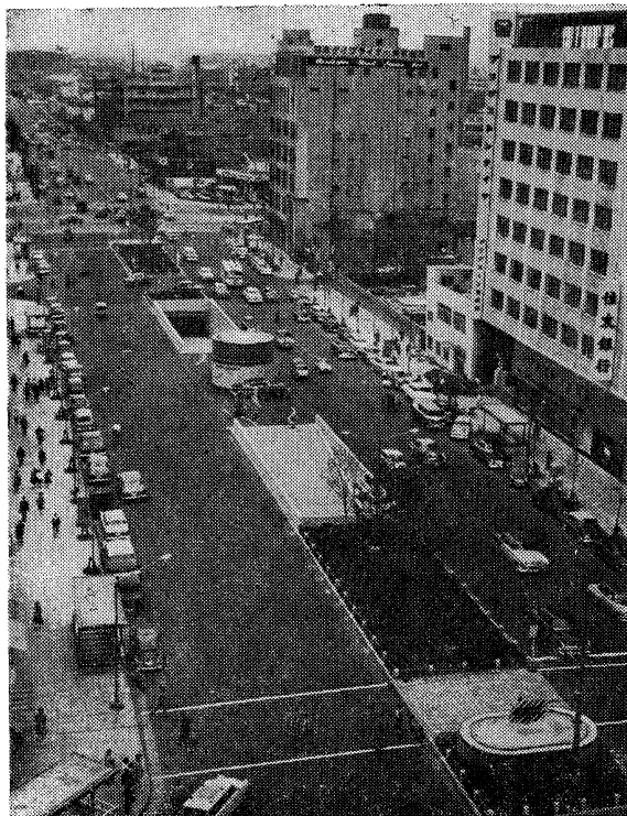
東京都八重洲駐車場
