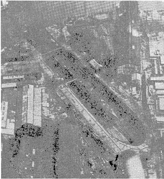
写真一 拡張工事着手前の全景
