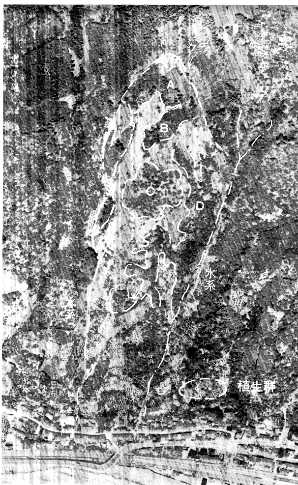
地すべり前の状況 (中部電力KK 提供)
