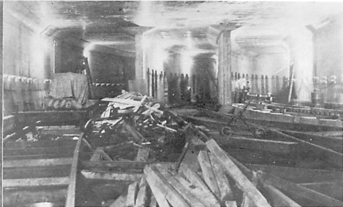
中野坂上駅三線部分の工事当時の状況
