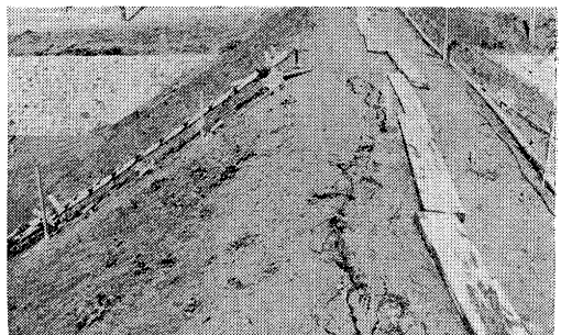
写真-5 降雨により生じたノリ崩れ
