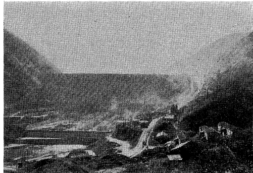
湛水のため仮排水路のゲートをおろした状況
