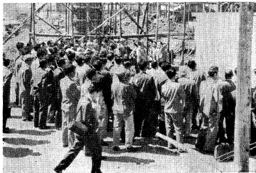
首都高速道路工事現場にて
