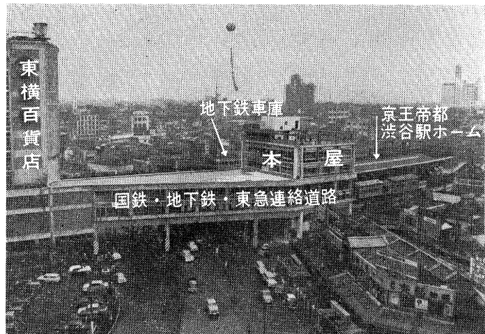
改良工事を終つた渋谷駅
