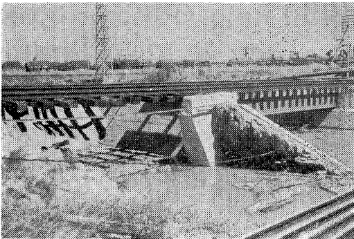
写真-6 蟹江駅付近復旧作業 (200m以上ほとんど連続したステージング)
