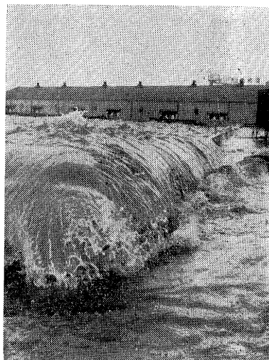
高潮による臨港埠頭の越水状況 (昭和 33 年 12 月 10 日)
