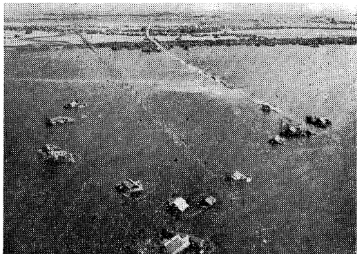
写真—13 国道1号線のドラムカン工法
