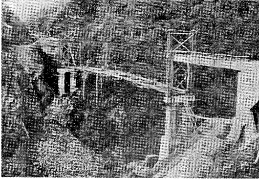
工事中の不動沢橋(昭34.6)
