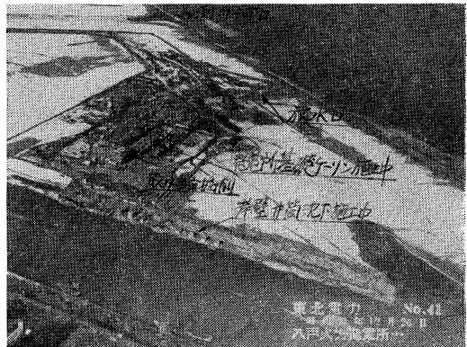
写真-4 施工状況全景
