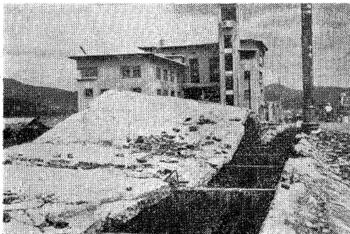
写真—2 被爆後の相生橋と商業会議所
