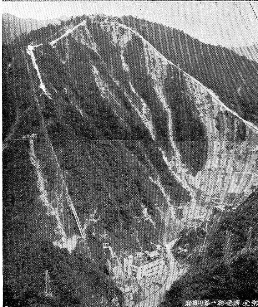
6月27日発電を開始した 和田川第一発電所
