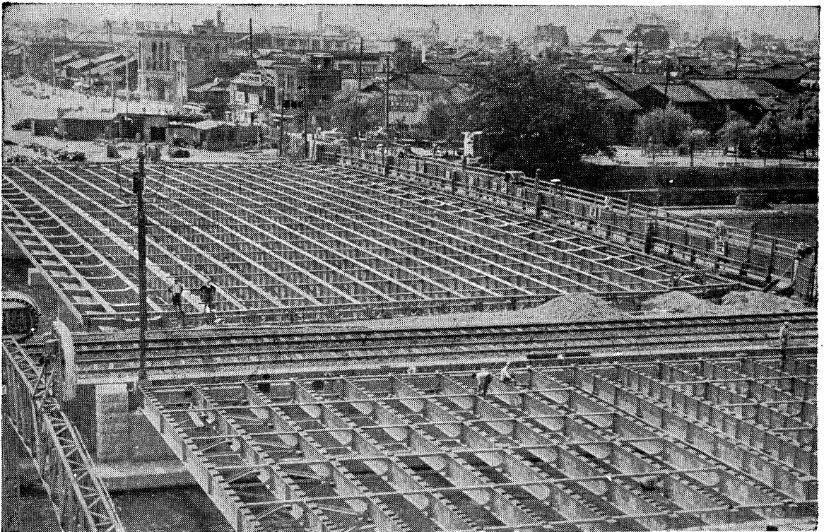
京都市役所 御注文 五条大橋並びに五条疏水橋（鋼桁架設状況）
