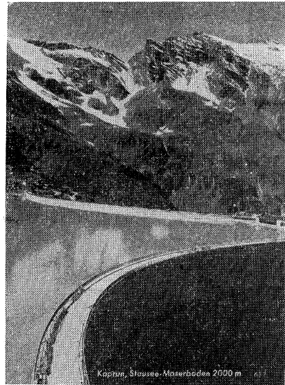
写真-4 カプルン発電所のモウザアアーチダム
