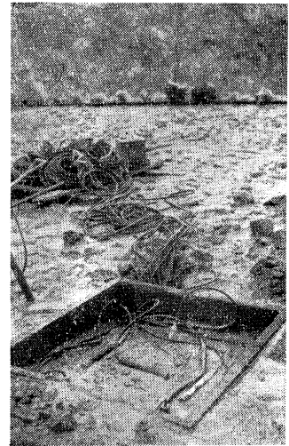
写真-4 ヒズミ計の埋設
