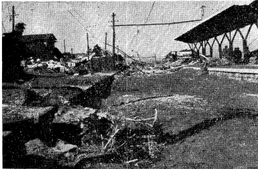
伊豆長岡駅構内 11.300 km 付近（構内の土石、流木状況）
