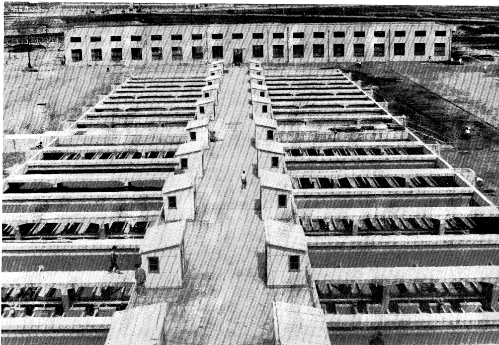
急速濾過場の回転式表面洗滌装置
