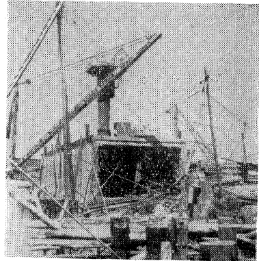
写真-7 艤装中のケーソン
