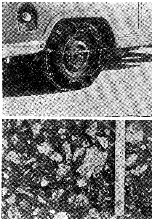
写真-8 タイヤチェーンと磨損した アスファルトコンクリート
