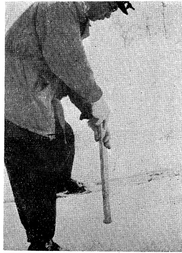
写真-6 スノー サンプラーによる積雪水量調査
